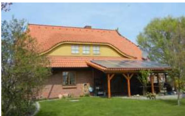
Photovoltaik-Anlage, Will GmbH, https://www.haustechnik-will.de/
